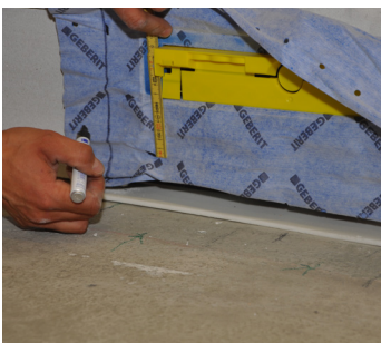
Dichtvlies ausbreiten und gemäss Vorgaben zuschneiden.
