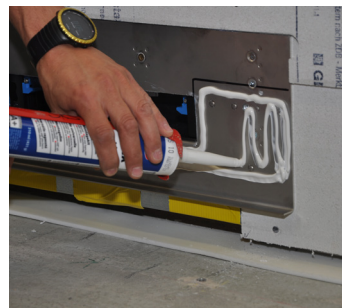
Dichtmasse-Kleber auftragen.
