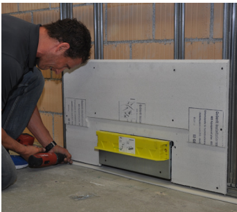
Aquapanel zuschneiden und montieren.
