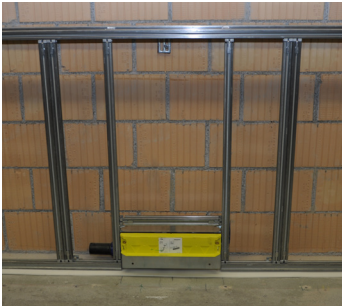
Geberit Duofix Vorwand und Wandablauf für Dusche montieren.
