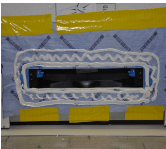
Dichtvlies straff oben und unten mit Klebeband fixieren und den Dichtmasse-Kleber auftragen.
