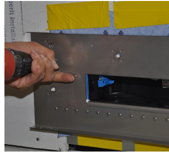
Dichtungsplatte anschrauben.
