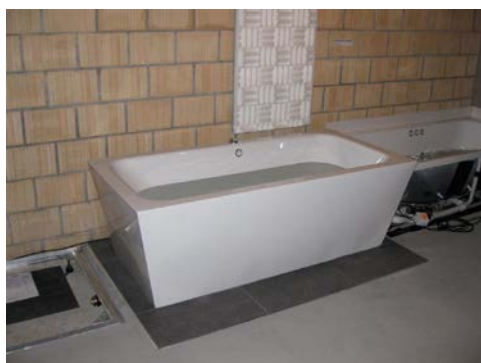
Illustration 1 : Installation dans le local d'émission
