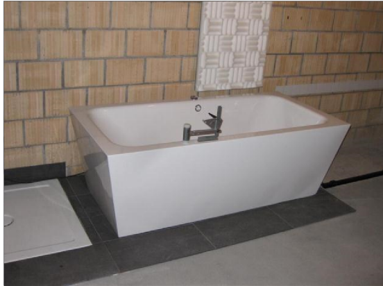
Abb. 1: Einbausituation im Anregungsraum
