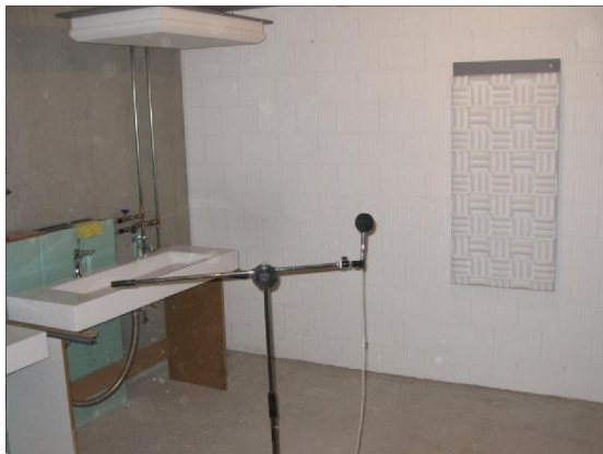
Abb. 3: Messstation UG - diagonal: Messraum 1.1
