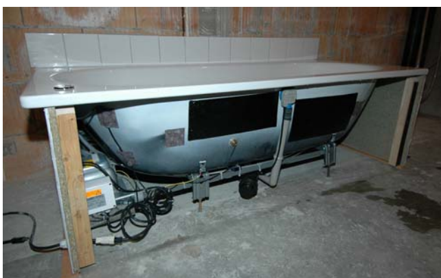
Abb. 3: Aufschnitt des Unterbaus, Einbau auf Rohboden
