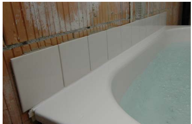
Abb. 2: Wandmontage einseitig mit Wandplatten und Silikon-Kitfuge
