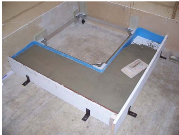
Abb. 1: Einziehen des Unterlagsbodens, 2 Wochen vor der Messung
