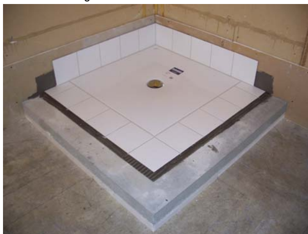
Abb. 3: 1 Tag vor der Messung wird die Floor eingebaut und mittels Silikonfuge gedichtet
